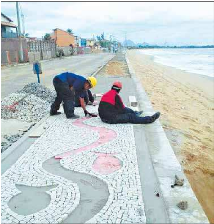
Funcionários trabalham para recuperar a orla de Tamoios, em Cabo Frio
