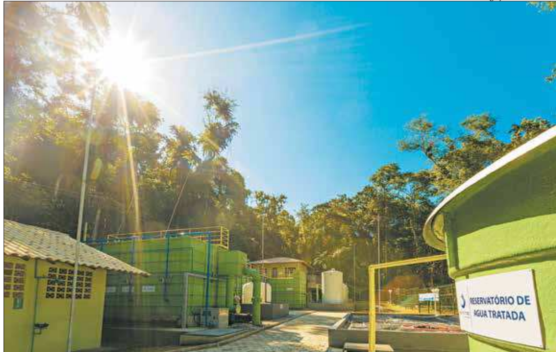
Melhorias estão sendo realizadas no sistema de reservação e distribuição de água no município de Paraty
