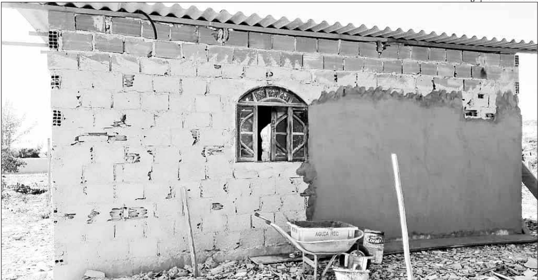
Casa estava sendo erguida no bairro Caiçara. No local, foi encontrado um homem trabalhando e material de obra
