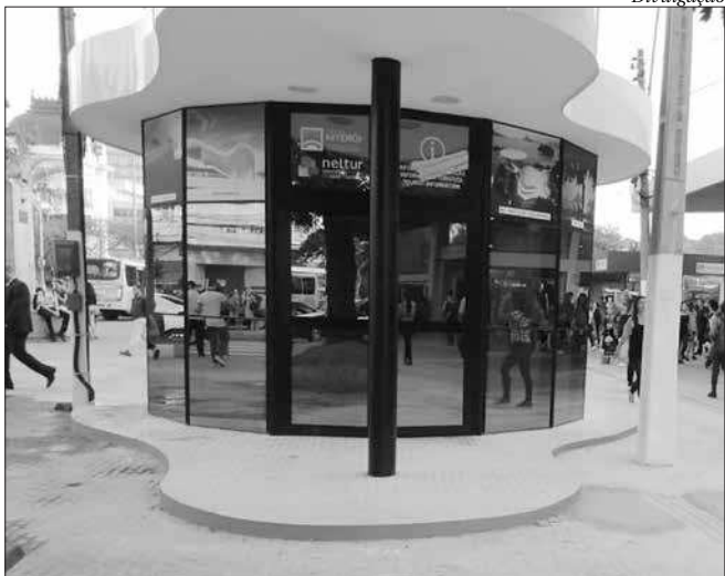
CAT será instalado na Praça Arariboia, em frente à estação das barcas
