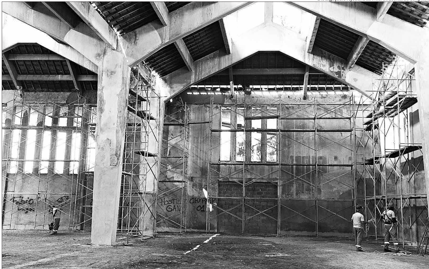
Com área de cerca de 9.700 metros quadrados, local estava desativado há cerca de 30 anos e agora recebe reforço estrutural e reforma nas colunas
