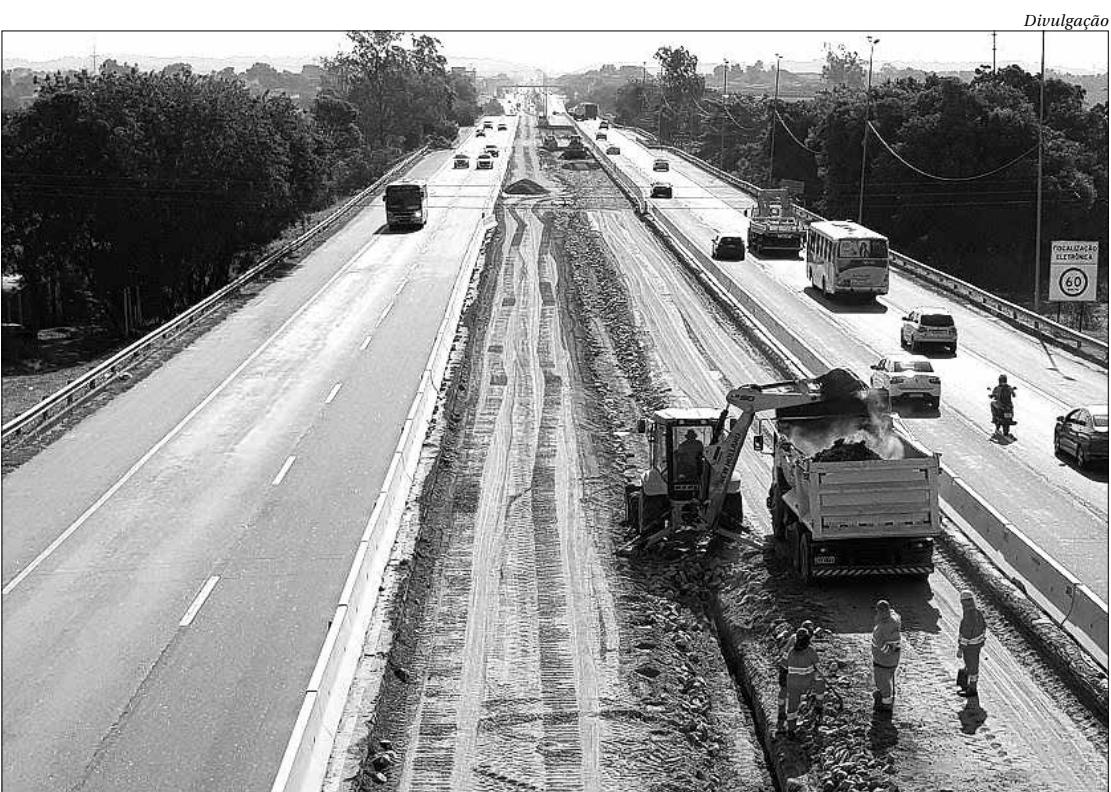
Trecho entre a praça de pedágio e o Trevo de Manilha será liberado ao trânsito na primeira quinzena de janeiro de 2020
