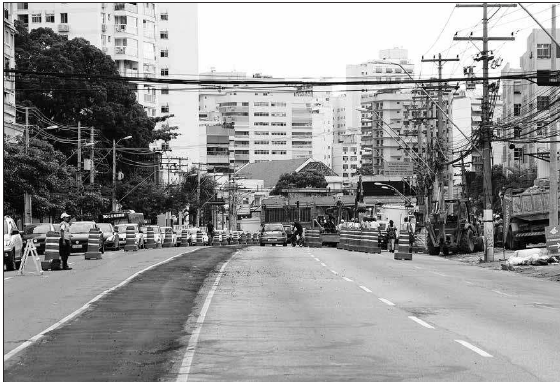
Sem o canteiro central, que foi retirado, a NitTrans utilizou de uma reversível para não complicar o trânsito na região
