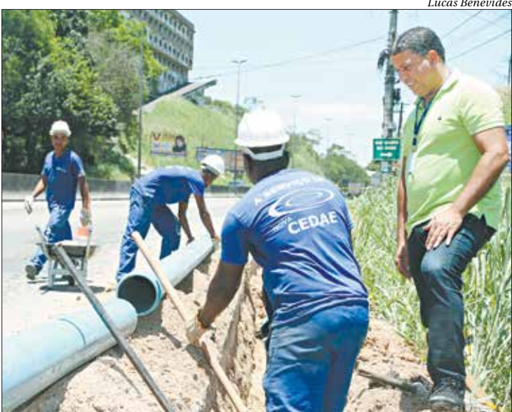
Equipes da Cedae deram início a novas obras para levar água a comunidades
