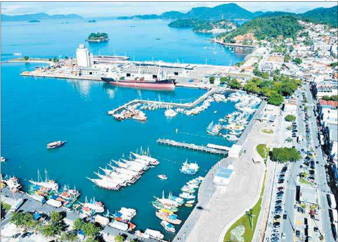
O Cais de Santa Luzia, em Angra dos Reis, é um dos pontos previstos na licitação de iluminação, prevista para fevereiro
