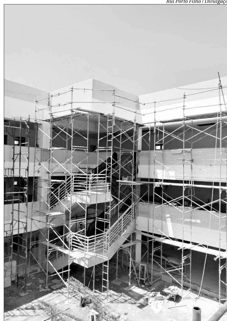
Através de verba da Prefeitura de Macaé, a UFF inaugura em fevereiro o bloco D
