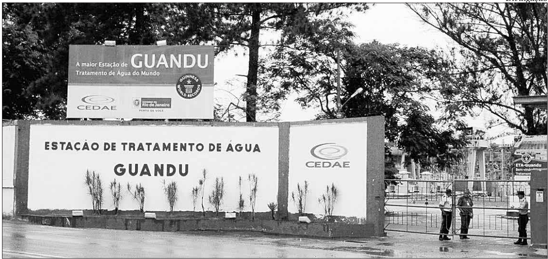
A Cedae informou que atual gestão identificou a necessidade da obra para garantir a segurança da captação
