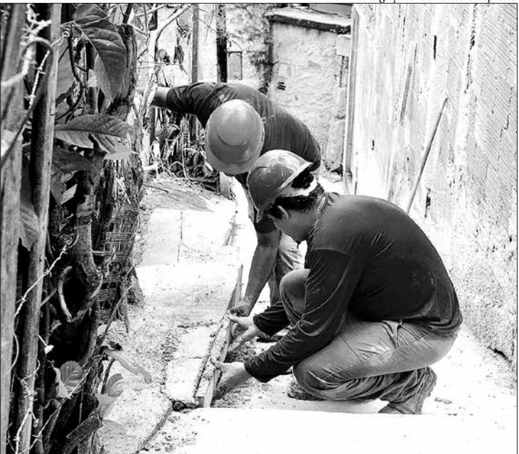
Em dezembro, foram iniciadas as obras de urbanização, com melhorias no acesso
