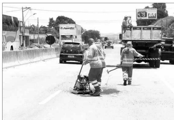
retirada do asfalto antigo e recapeamento; pintura de ligação; micro revestimento; 740 metros de dreno profundo para diminuir o
