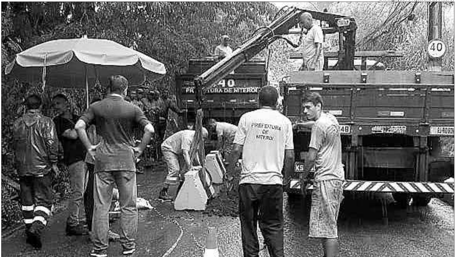
A Emusa informou que, nas próximas semanas, será dada a ordem de início para as obras de urbanização das comunidades do Viradouro e União
