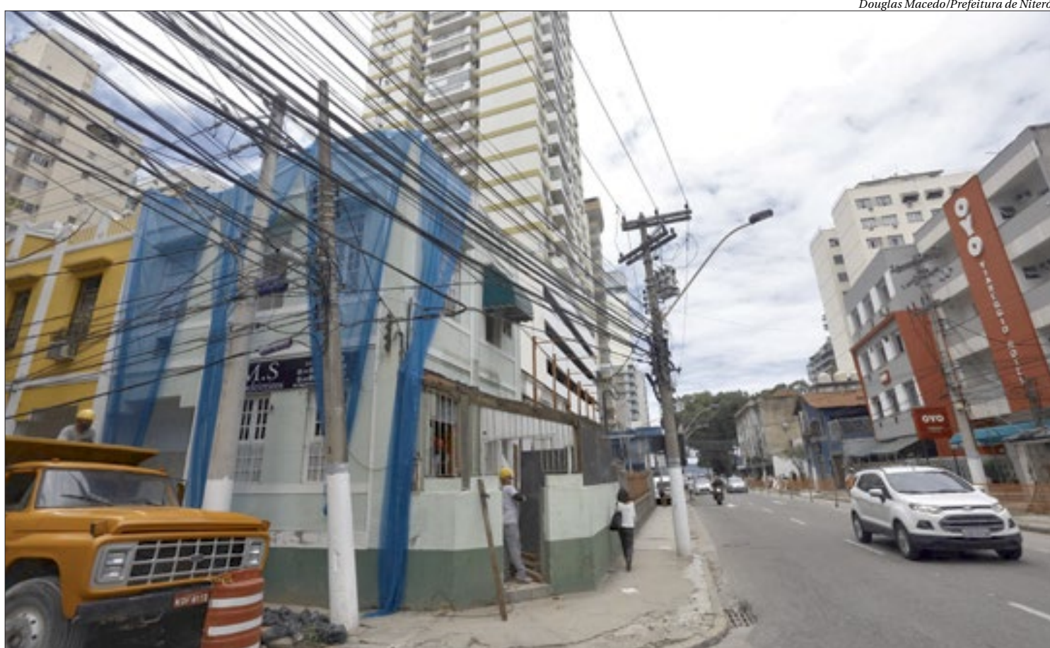
A Paulo Alves passará de três para quatro faixas para veículos, no trecho entre ruas Presidente Pedreira e Casemiro de Abreu, sendo a quarta faixa para ônibus
