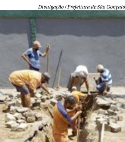
Prefeitura acelera obras para acabar com alagamentos sob o viaduto do Gradim
