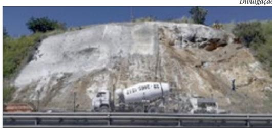
A CCR ViaLagos faz obras de contenção e reforço de talude, no km 05, em Rio Bonito, na pista em direção à Região dos Lagos. O trabalho consiste na recuperação da encosta com a utilização da técnica
