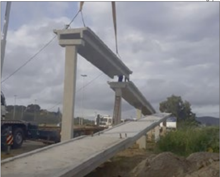
Passarela na RJ 106 está sendo erguida em frente à UPA do bairro Balneário
