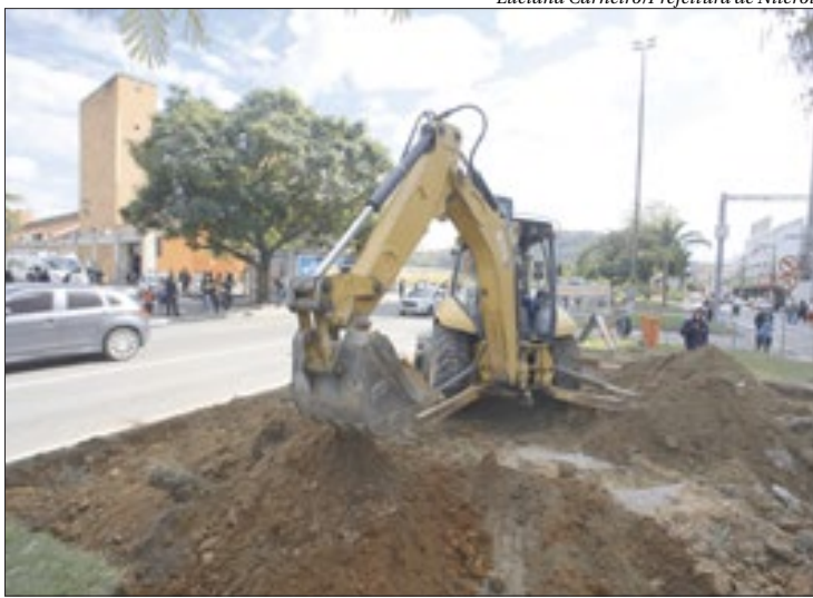
Obras para melhorar trânsito no Centro de Niterói estão sendo realizadas
