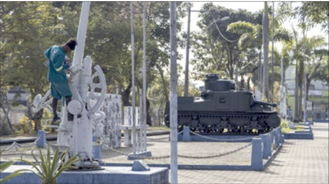
Praça dos Ex-Combatentes, em São Gonçalo, é revitalizada para dar mais conforto e segurança aos frequentadores
