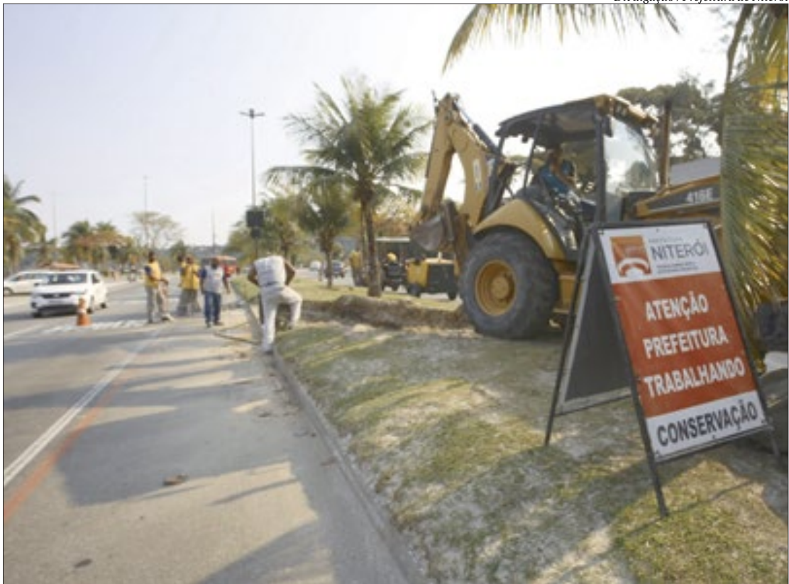
O local da obra já começa a tomar forma e conta com agentes da NitTrans para a orientação do trânsito na região
