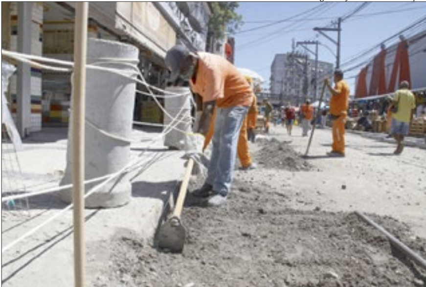
Revitalização na Estrada Raul Veiga: primeira quadra vai se transformar em passeio público
