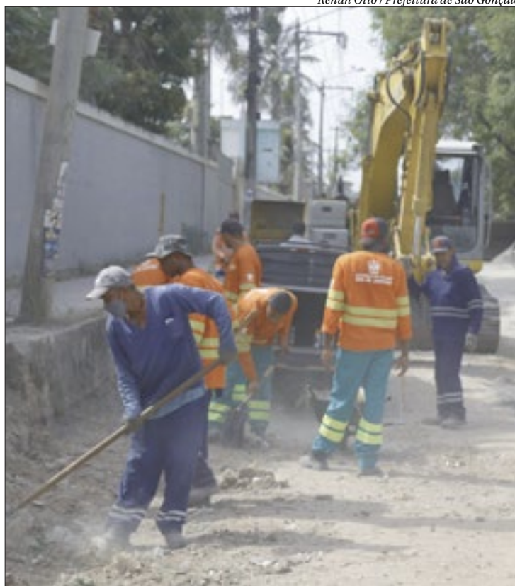
Equipes trabalham em ritmo acelerado nas obras de infraestrutura no Bichinho
