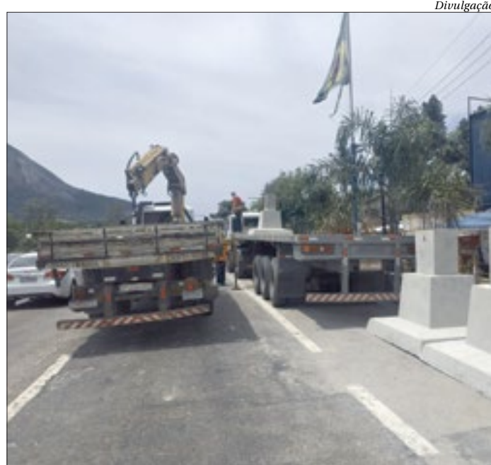
Equipes realizam reforço estrutural em passagem subterrânea
