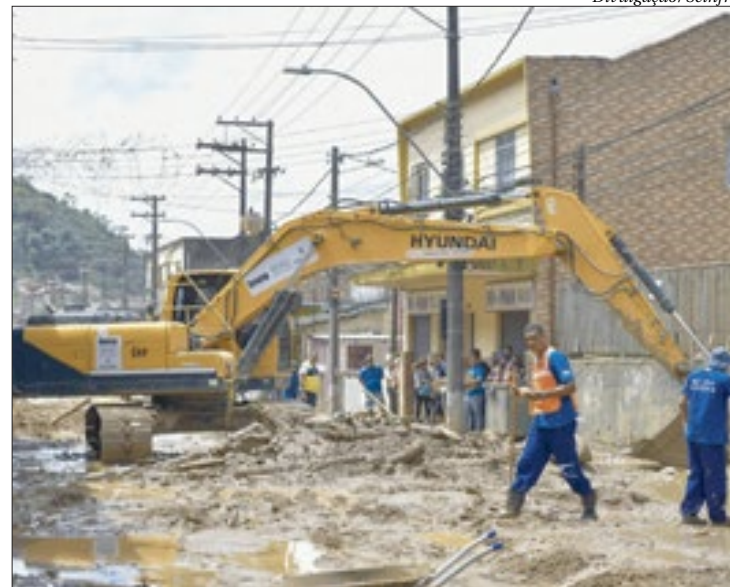
Os serviços seguem em ritmo intenso pelas ruas da Cidade Imperial
