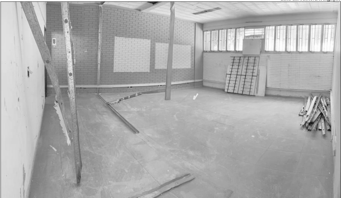
As obras seguem em ritmo acelerado e as novas instalações ficam praticamente ao lado do prédio atual
