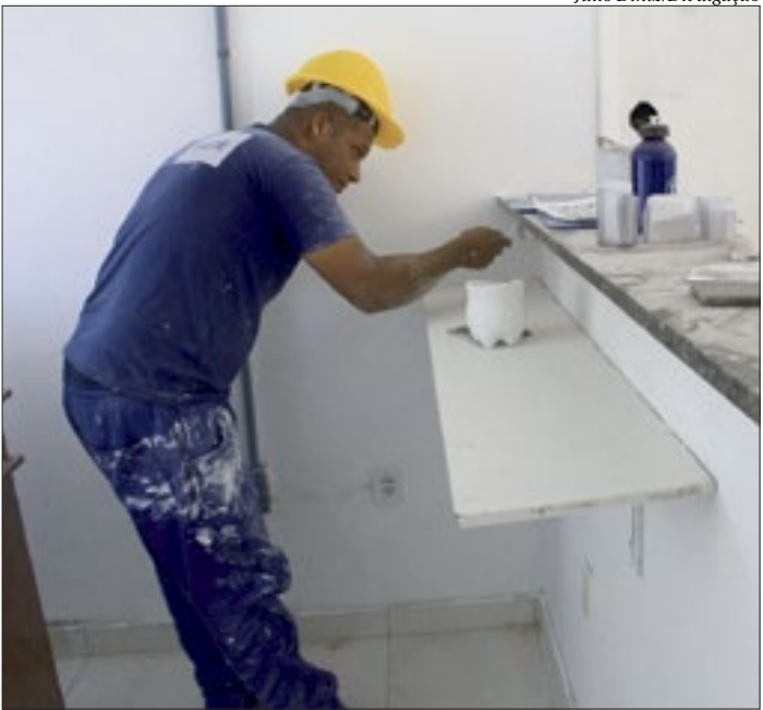
As obras de adequa  o ser o realizadas em cerca de 20 unidades em 2022
