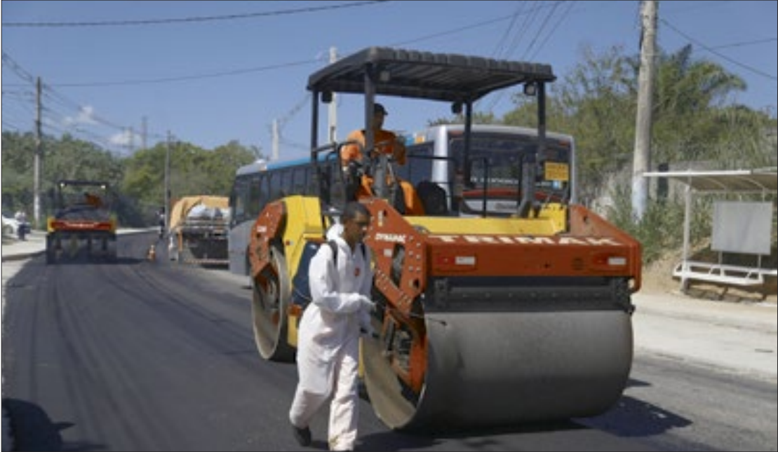
Estrada de Guaxindiba recebe asfalto após trabalho de drenagem: ligação importante entre a BR-101 e a RJ-104
