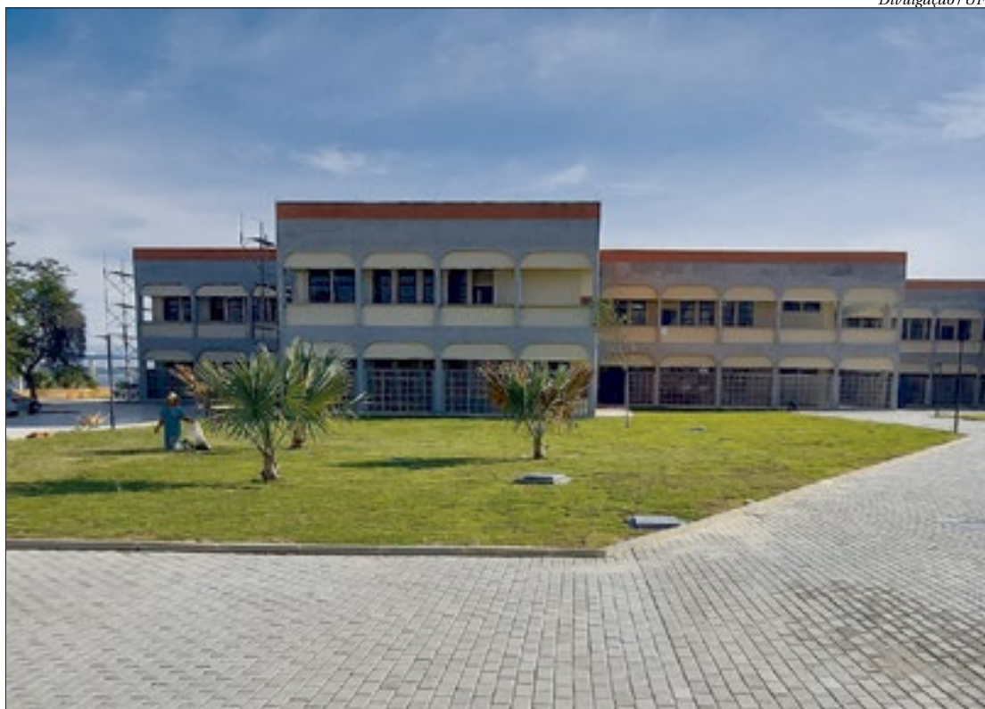
Com administração e parcerias, a UFF segue com obras pelo estado levando mais conforto e qualidade para os alunos
