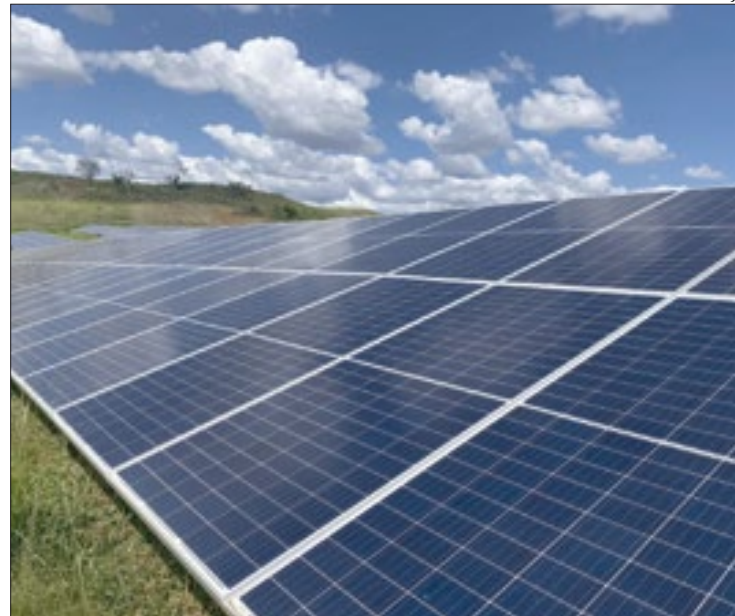
Dois usinas já estão em fase de construção em Nova Friburgo, Região Serrana
