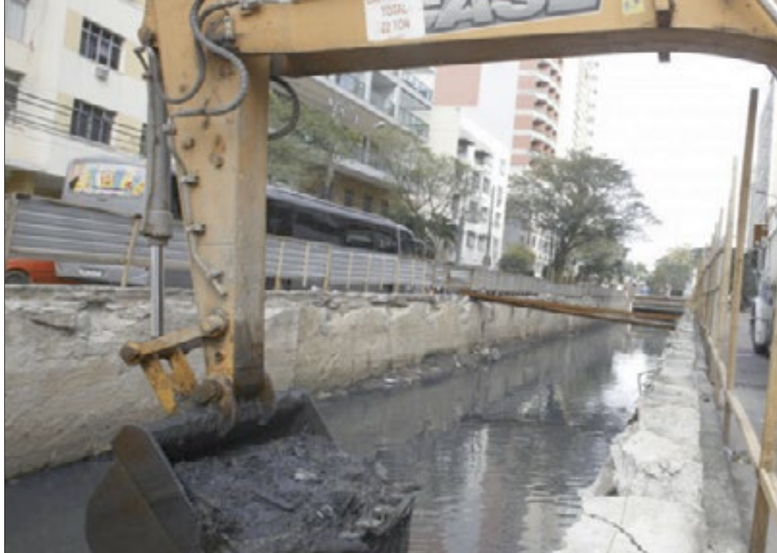
Primeira etapa de obras já começou. A partir de segunda haverá alterações no trajeto de algumas linhas de ônibus
