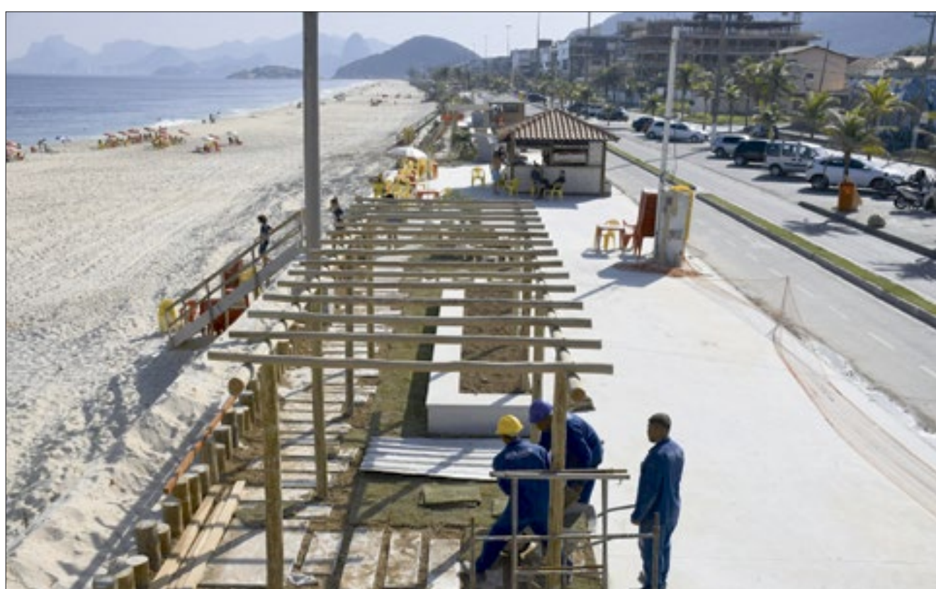
Detalhes de paisagismo já estão sendo realizados no trecho, como construção de canteiros, pergolado e colocação de gramado
