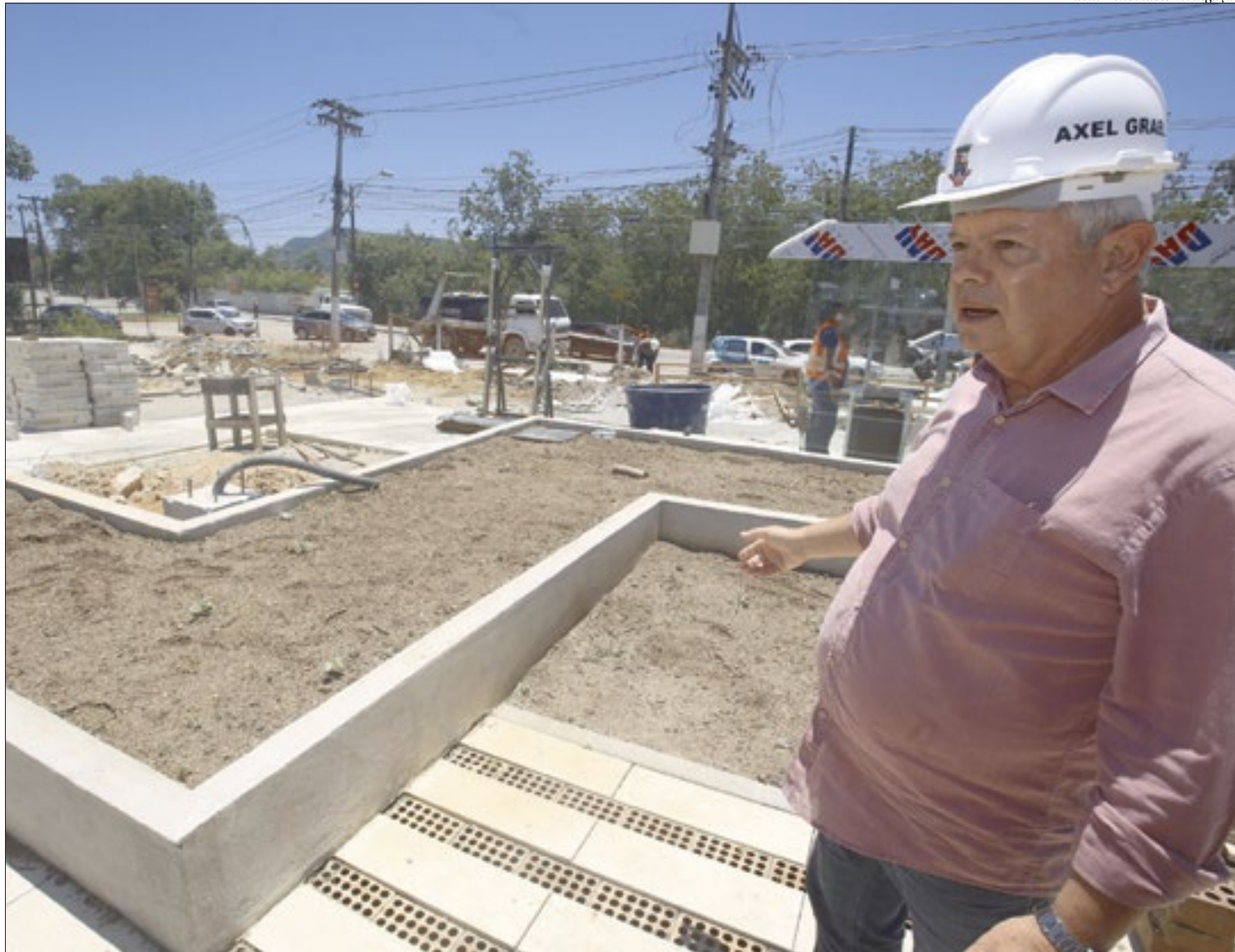
Com a primeira parte prevista para ser entregue no próximo dia 22, obra realizada em Camboinhas foi vistoriada pessoalmente pelo prefeito Axel Grael
