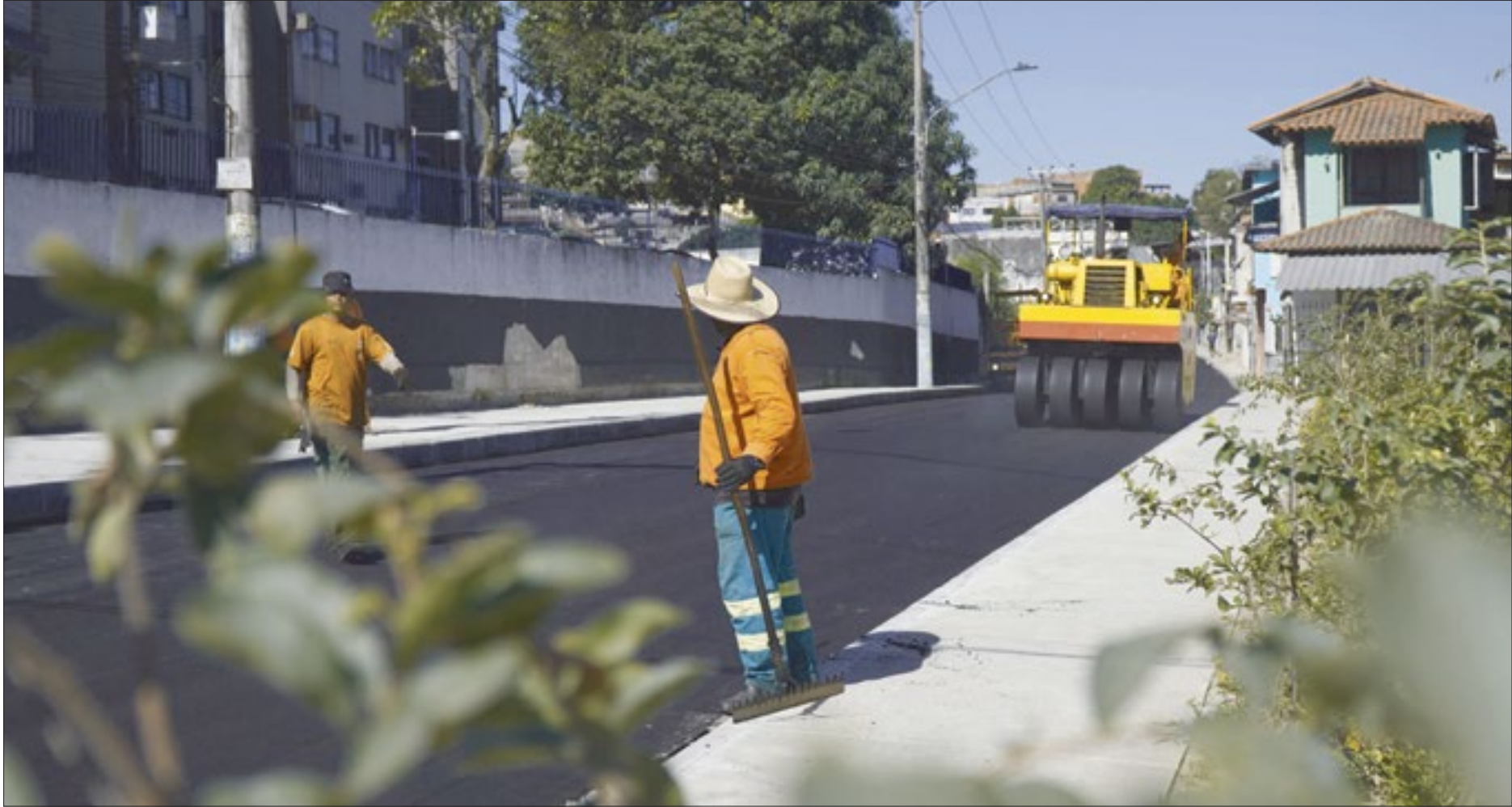
Operários trabalham no asfaltamento da via. Próxima etapa será pintura da sinalização, instalação de placas e sinais de trânsito. Após os serviços, o desvio do trânsito será efetivado
