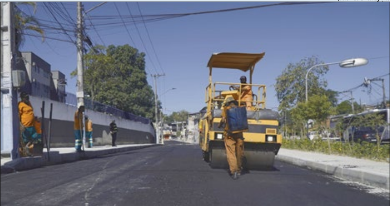
A Travessa Malafaia já está sendo asfaltada para receber o fluxo de veículos que será desviado de outras vias a fim de melhorar o trânsito na região
