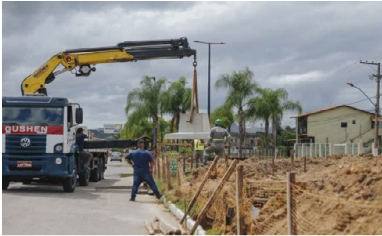
Em Maricá, diversas rodovias devem receber melhorias
